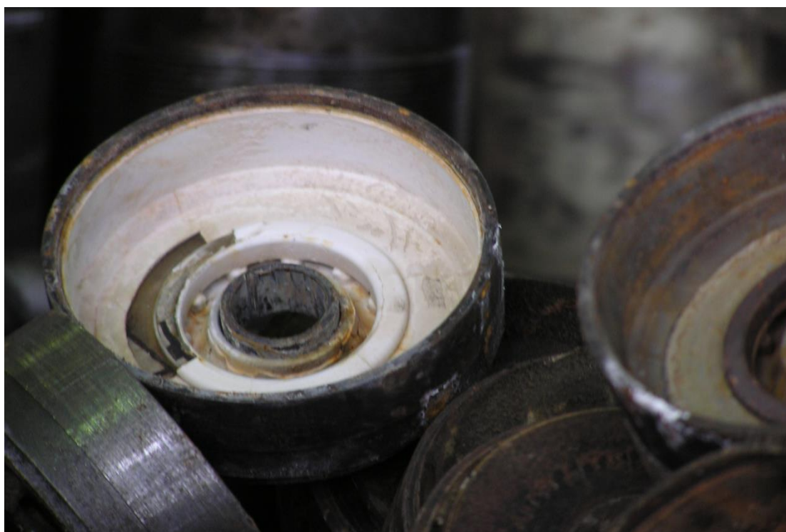
Рисунок 12 - Твердые отложения на колесных аппаратах насоса
